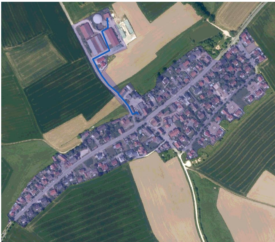
Abbildung 75: Übersicht über das Quartier „Bertelsdorf“ mit der bestehenden Nahwärmeleitung
