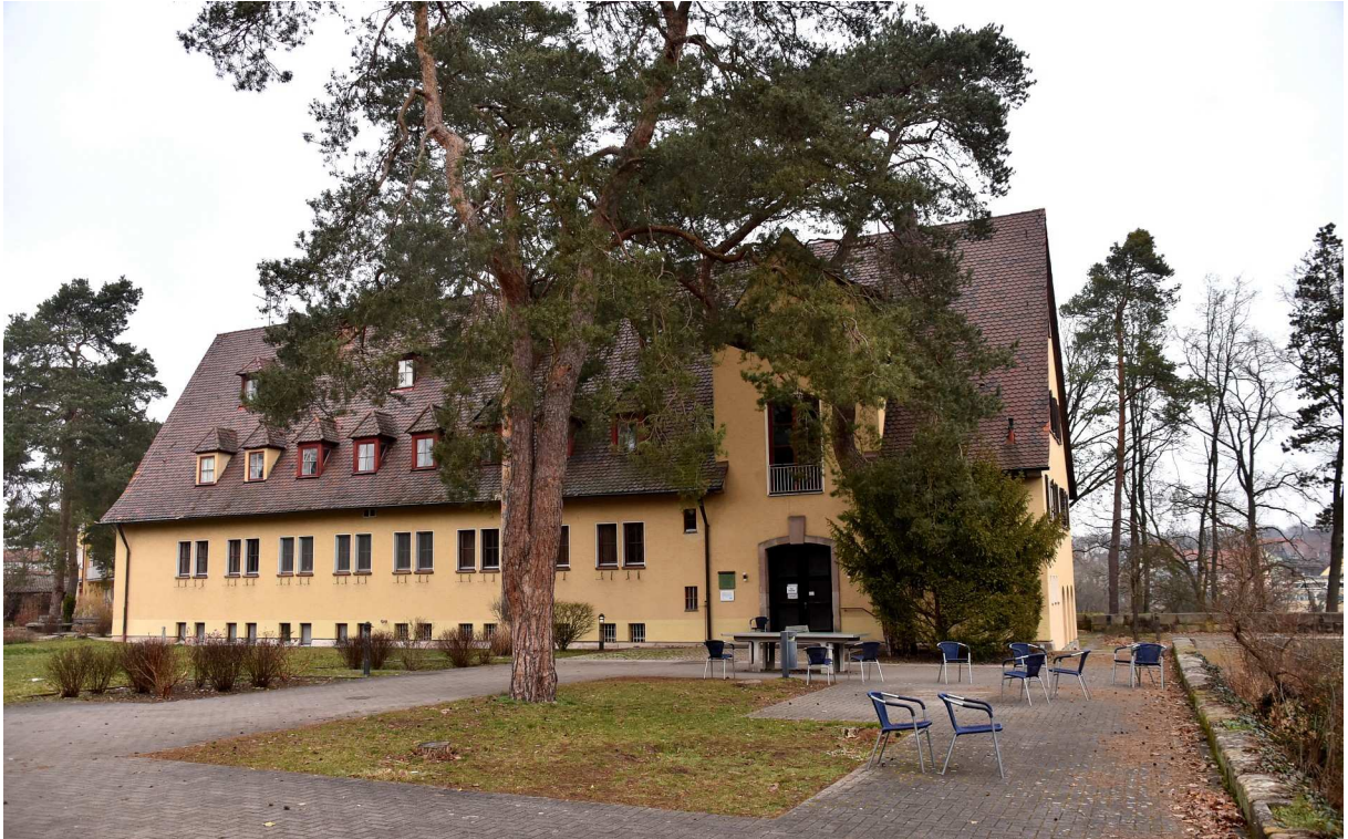
Abb. 4: Südseite des Nebengebäudes (Foto FEHSE 01.03.2024)
