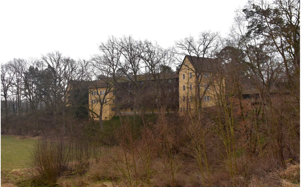
Abb. 2: Blick nach Südosten auf das Hauptgebäude (Foto FEHSE 01.03.2024)
