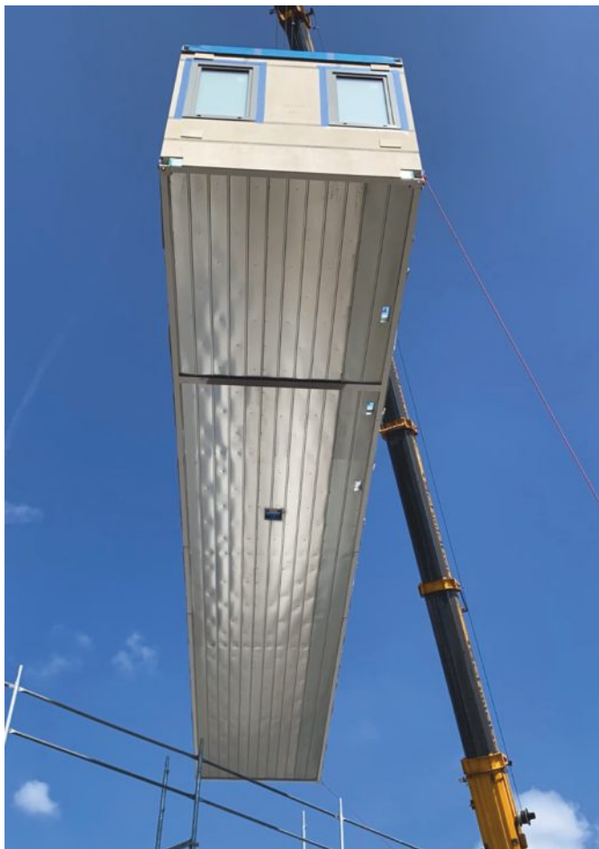
Eines von insgesamt 20 Modulen beim Bau des neuen Hortes in der Mühlstraße. Foto: Stadt Stein
