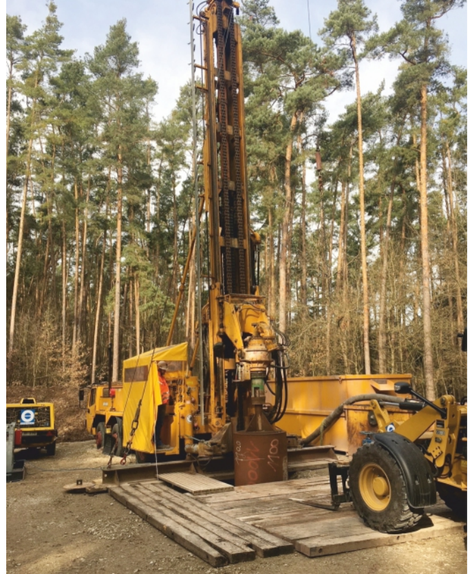
Überbohrung Brunnen II. Foto: Wasserzweckverband Großweismannsdorf
