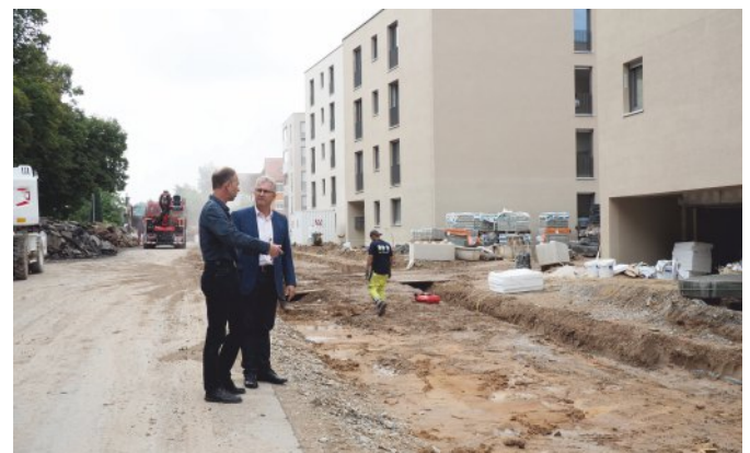
Bürgermeister Kurt Krömer (rechts) und Bernd Predatsch vom Stadtbauamt (links) machten sich vor Ort ein Bild von den laufenden Bauarbeiten in der Deutenbacher Straße. Foto: Stadt Stein
